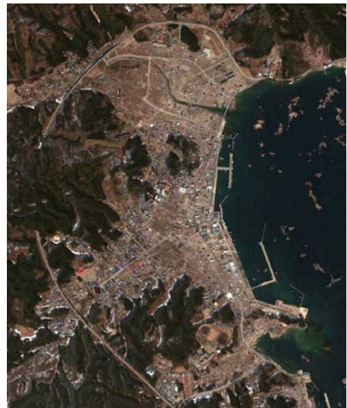
写真2 三陸縦貫自動車道
